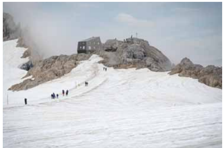
Abb. 3: Seethalerhütte, Hoher Dachstein
