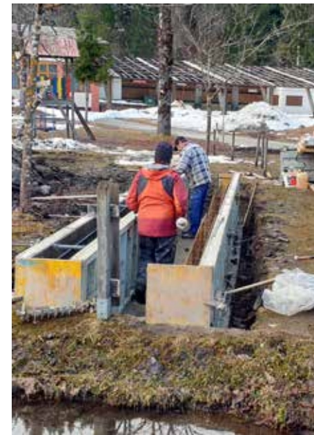
Foto: Schalungsarbeit am Kneipp-Kanal
